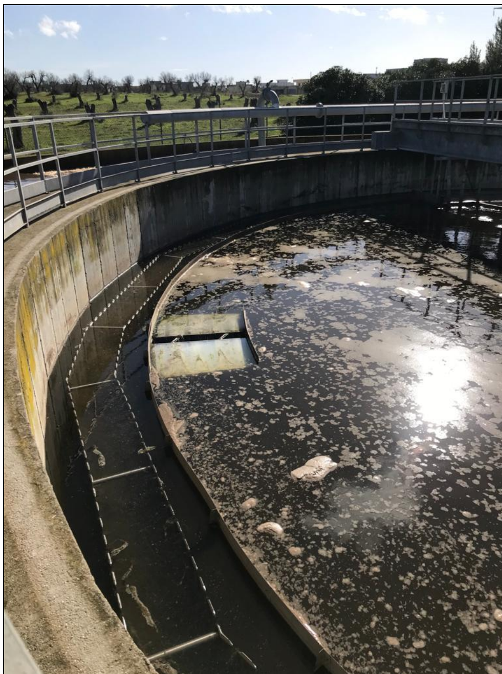
Foto 1. Area impianto: sedimentatore.
